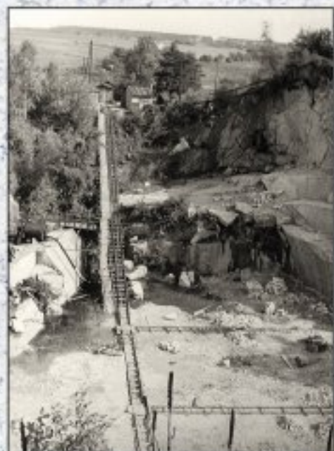
Duškův lom – ze fotografie je vidět způsob dopravy kamene z lomu. Vozička od stěrek hlavní koleji a po ní pomocí lan na postrch.
