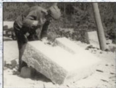
Kameník tvaruje vytěženou žulu pomocí dláta a mlátka.
